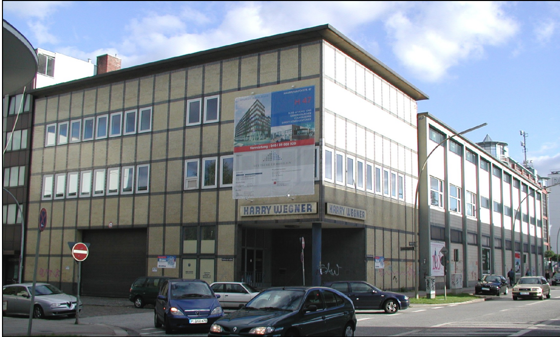
Bestandsgebäude HARRY WEGENER
