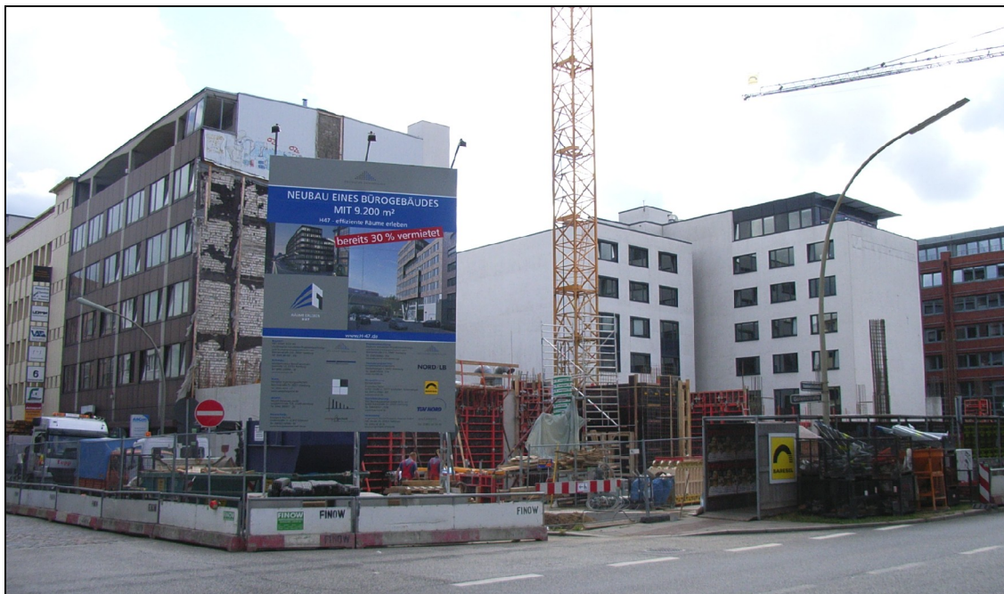
Baustelle der Deutsche Immobilien AG
