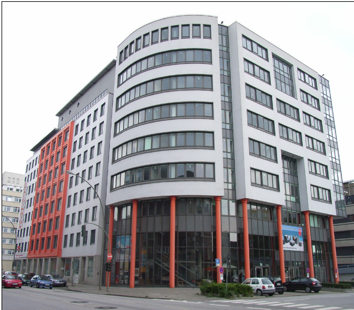
Bürohaus Spaldingtor nach Umbau und Erweiterung
